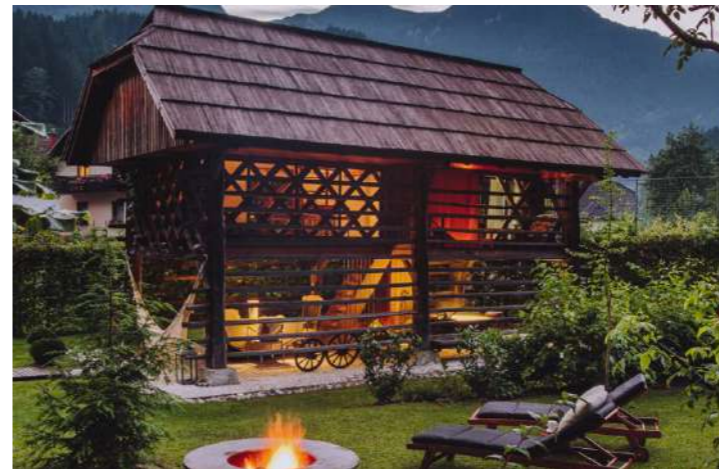
Hiša Raduha, Luče Kozolec kot luksuzno prenočišče za turiste (je v celoti prenovljen in v pritličju ima ogrevan bazen). Energetska sanacija objekta je bila so-financirana s strani Evropskega sklada za regionalni razvoj. / Kozolec come lussuoso alloggio per turisti (il kozolec è interamente ristrutturato: il piano terra è un soggiorno all'aperto con piscina, al primo piano c'è il bagno e al secondo la camera da letto). Il progetto di recupero e adeguamento energetico è stato co-finanziato dall'Unione europea.
